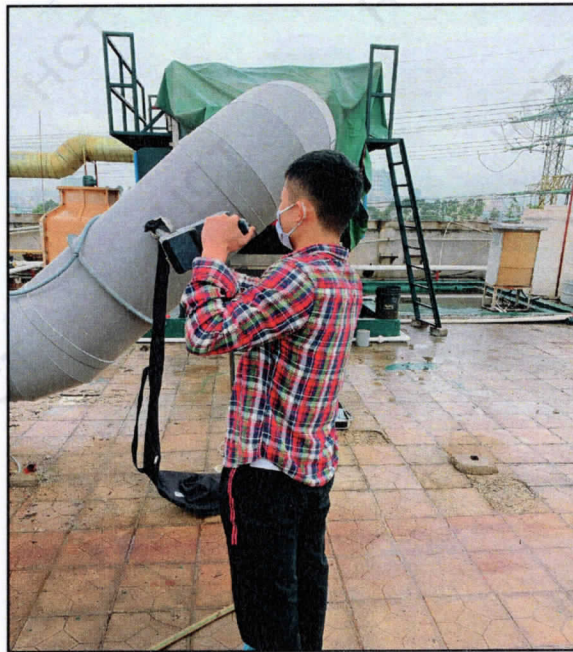
工业废气处理后检测口 (DA002)
